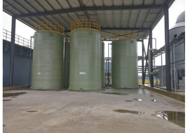
废水处理站药品储存区
