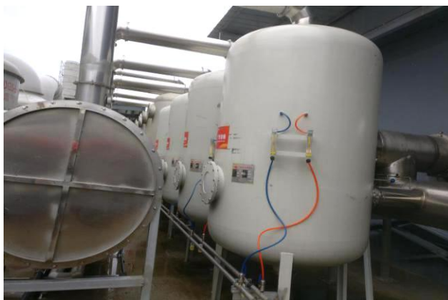
东侧末端燃烧桶（10套）
