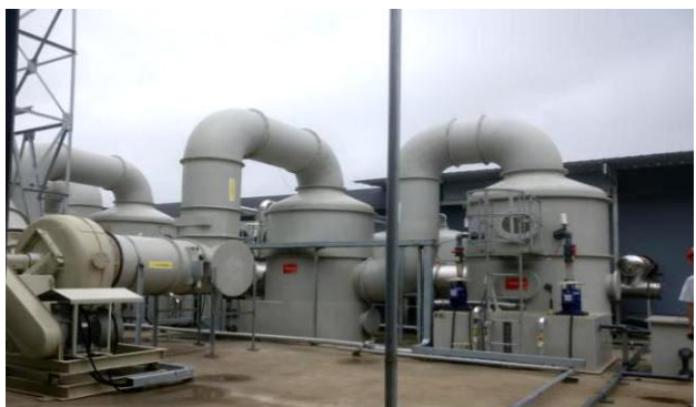
东侧二级喷淋塔（2套）
