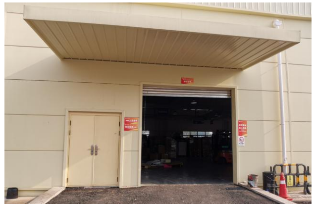
一般固废暂存库
